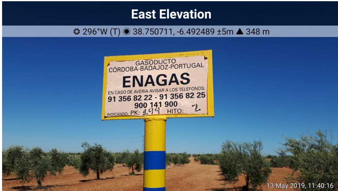
Figura 31. Fotografía información hito gaseoducto
