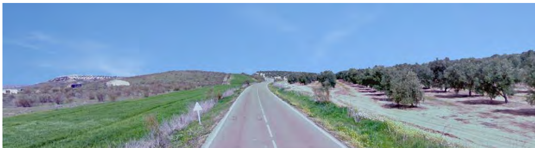
Figura 36. Carretera BA-001, presente y elemento dominante en el ámbito de implantación.
