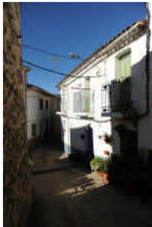
Vista de fachada principal desde el E
