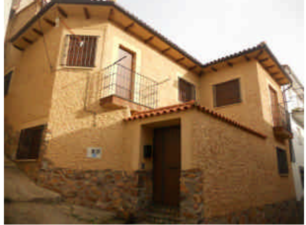
Vista de la fachada principal
