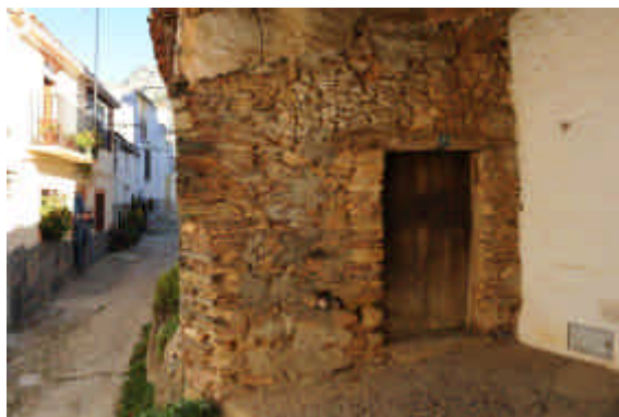
Vista porche de entrada nº8
