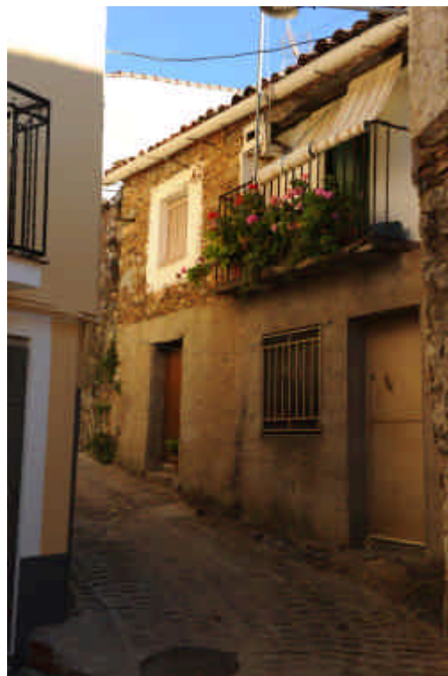
Vista de la fachada desde el SW
