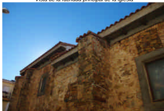
Detalle de reformas en hormigón
