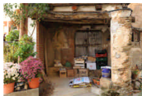
Detalle de porche de entrada
