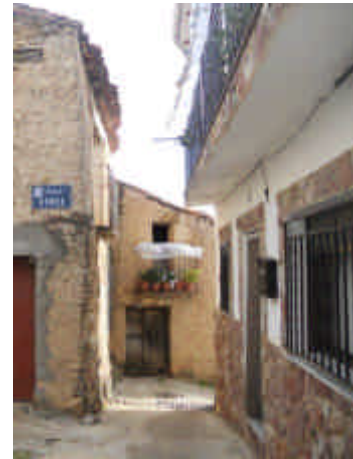
Vista de fachada N y balcón
