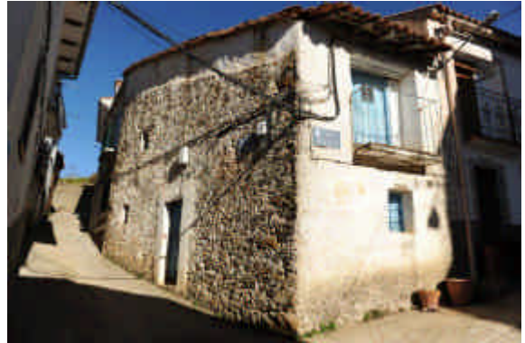
Vista desde la calle Arroyo
