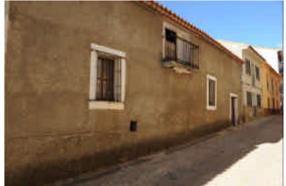
Vista de la fachada desde el S
