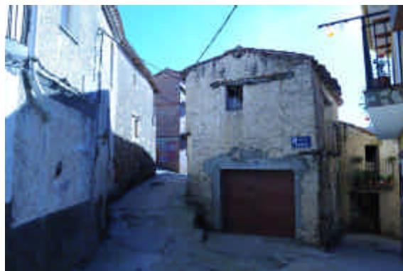
Vista de fachada N y balcón W
