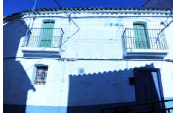
Vista de fachada principal
