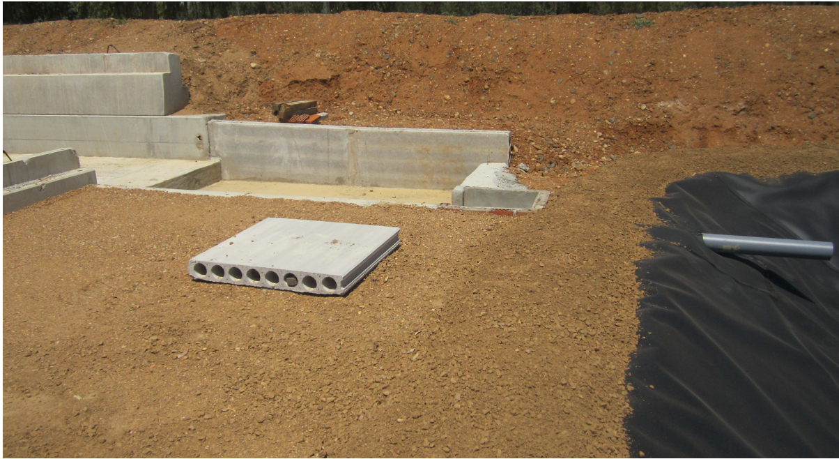
Foto de el desarenador previo a la balsa.
