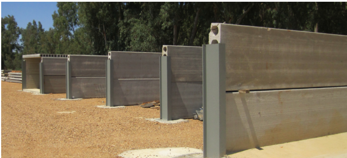
Foto de la zona de celdas construida.
