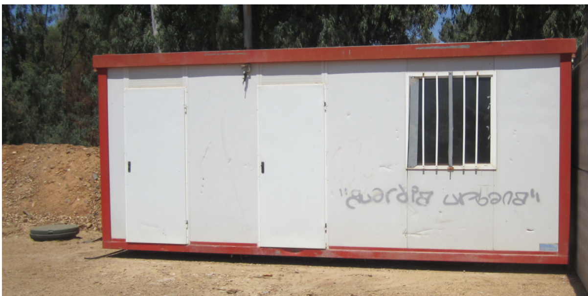
Foto de la caseta instalada.
