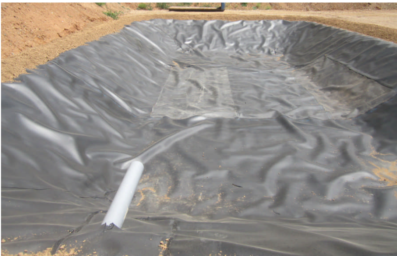
Foto de la balsa impermeable construida
