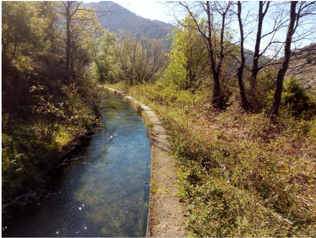
Punto donde conecta la nueva tubería con el abastecimiento a Viandar
