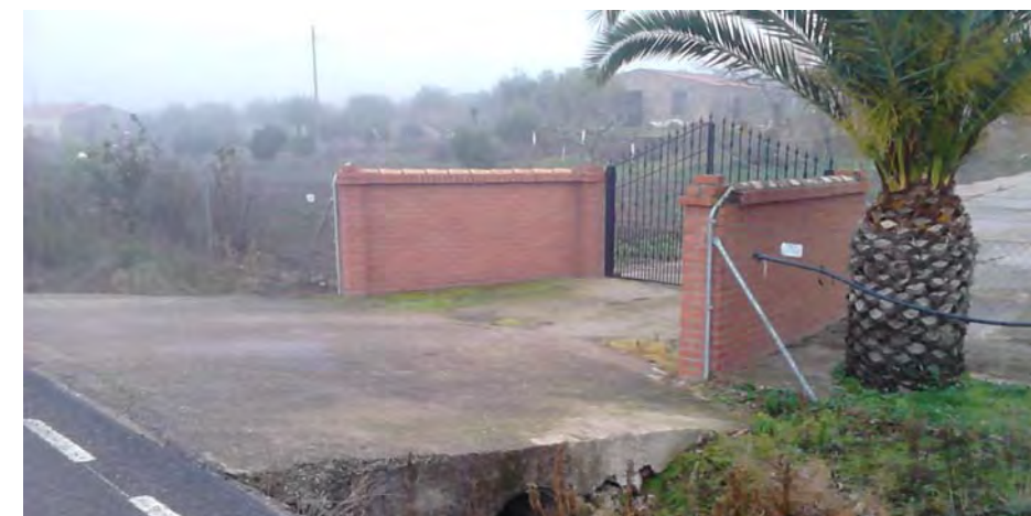
Imagen representativa del cerramiento y obras de entrada existentes en las parcelas de la margen derecha
