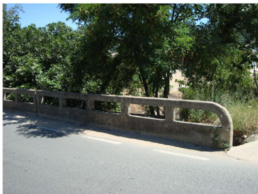
Puente estación - Sur - Foto B.
