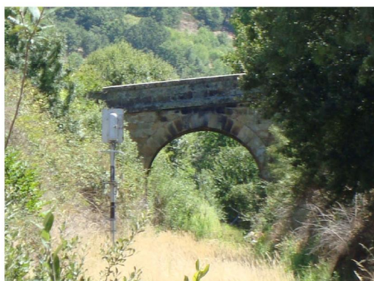
Puente estación - Norte - Foto A.
