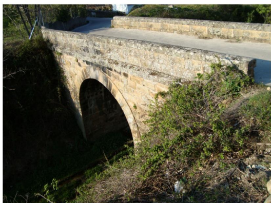
Puente estación - Norte - Foto B
