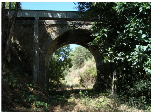
Puente estación - Sur - Foto A.
