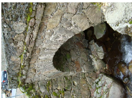
Pontón en carretera al Puerto H
