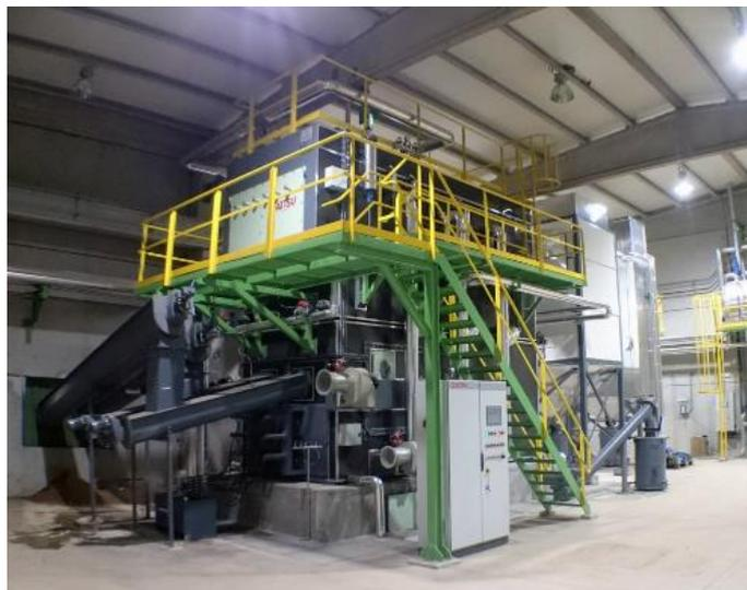
Con esta caldera de biomasa se realizará la generación de agua caliente necesaria para el calentamiento de los digestores y la producción de vapor saturado necesario para el proceso de higienización de SANDACH.
